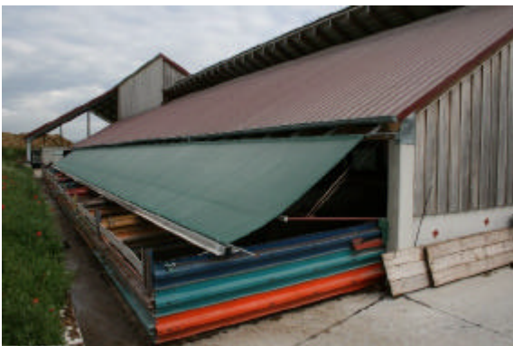
Betrieb 4: Die Auslaufbegrenzungen sind teleskopartig ausgefahren
