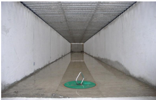
Das Wasser im Kanal kühlt die Luft durch die freiwerdende Verdunstungsenergie und erhöht die Luftfeuchtigkeit Wasserstand 5 cm.
